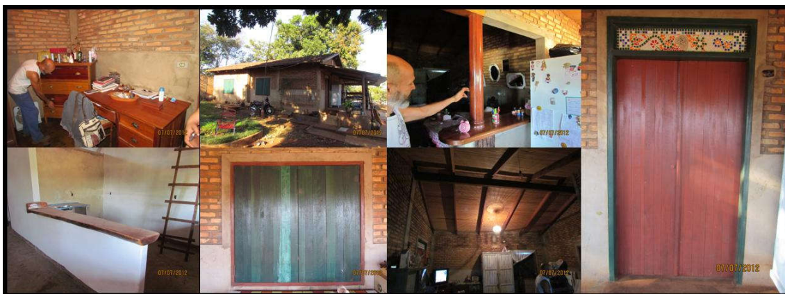
Figura 7 Utilização de resíduos para componentes em novas construções: portas, janelas, tijolos, telhas, cobertura, em Jataí (Vila Sofia)
